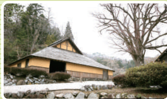
菅谷高殿外観
